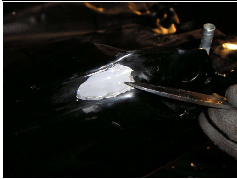
Abb.: 6.3-1 – Grobe Form mit Messer herstellen
