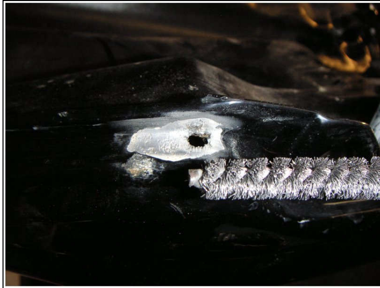
Abb.: 6.1-2 – Schadstelle mit Drahtbürste freilegen
